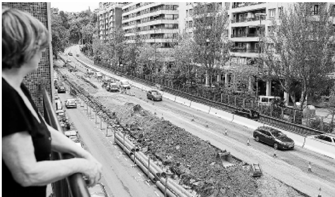
Una mujer se asoma para ver las obras. Foto: G. Estrada
